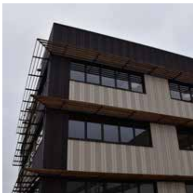
Nouveau bâtiment, alliant modernité et efficacité
